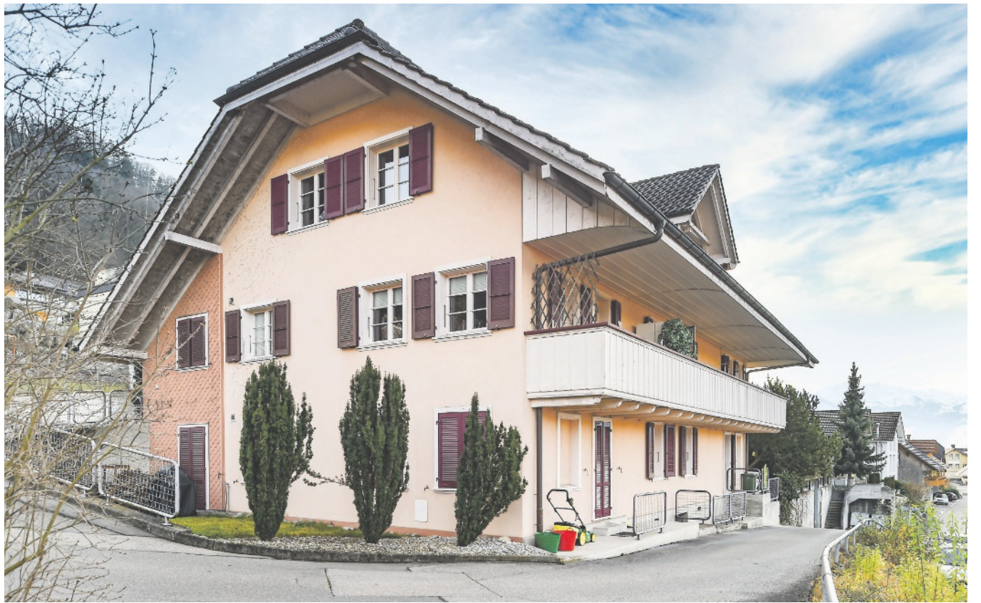
Im sanierten Bauernhaus aus dem 19. Jahrhundert sind fünf Mietwohnungen untergebracht. Mit der neuen Heizungslösung werden Raumwärme und Warmwasser nun zentral durch Nutzung des kostenlosen Energieträgers Luft aufbereitet.
